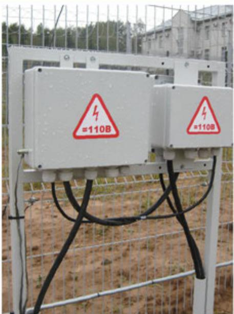
При обрыве или замыкании нитей сигнализационного заграждения выдаётся сигнал тревоги.
